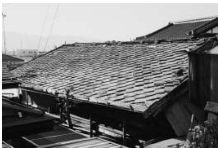
平石葺き（菱葺・平葺）屋根の倉／切妻屋根の2面が菱葺と平葺
