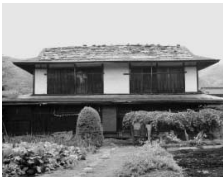
長板葺き屋根／現在、石の下はトタン葺き
