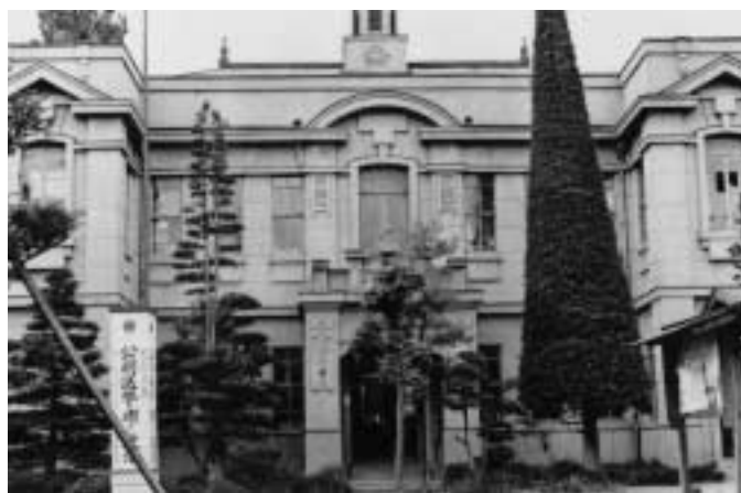
旧永明村役場／茅野市ちの／大正15年／現存しない
