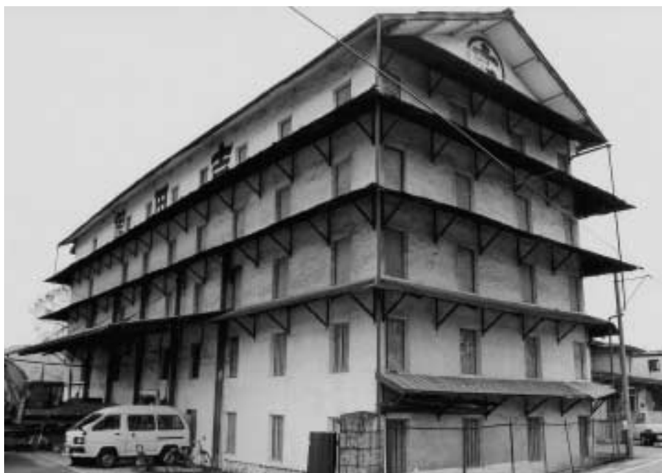
5階建て繭倉庫／岡谷市銀座／明治26年／吉田館／現存しない
