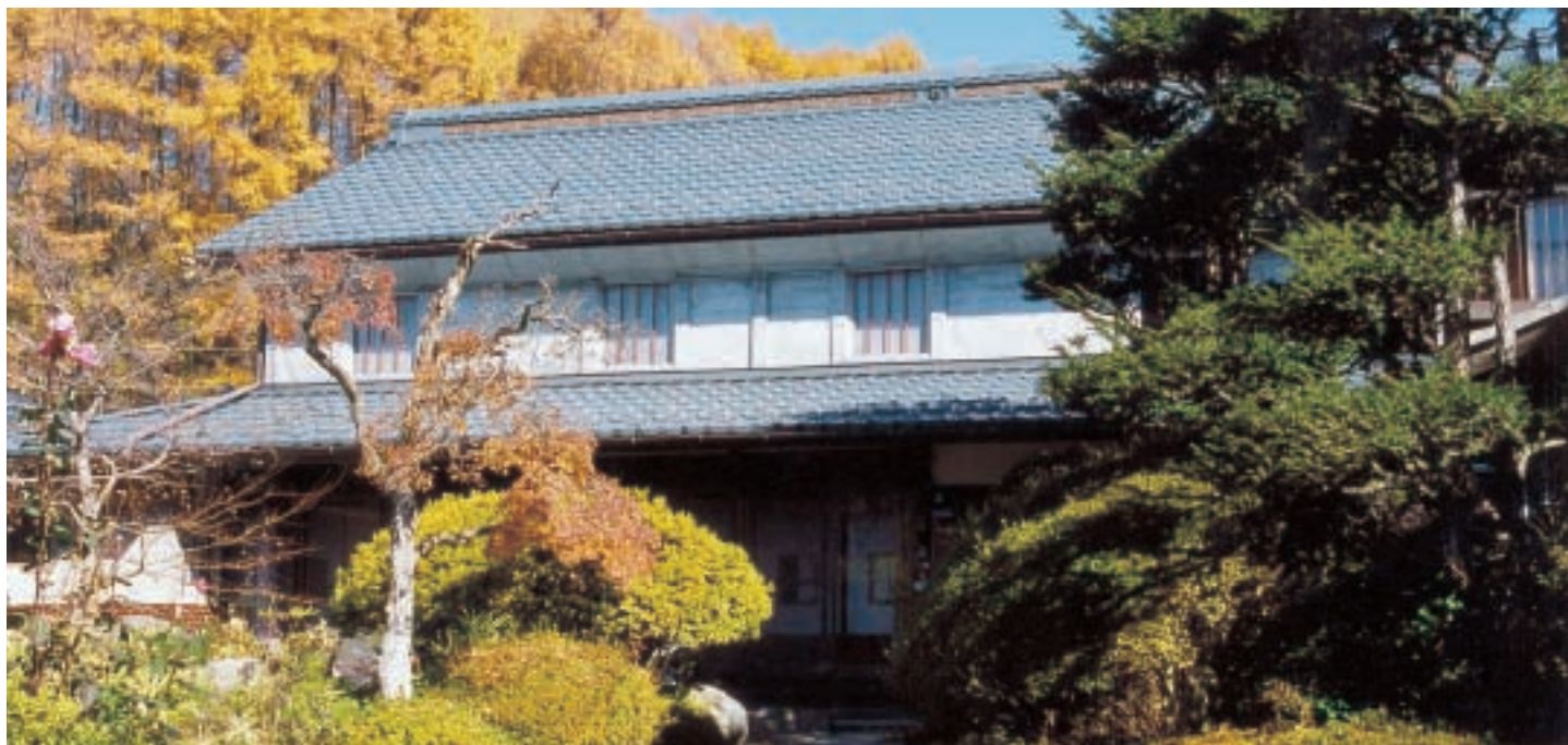
坂室の蔵造り／茅野市宮川／大正／2階は寒天倉庫
