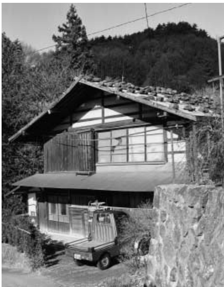
長板葺き屋根／現在、石の下は波トタン葺き
