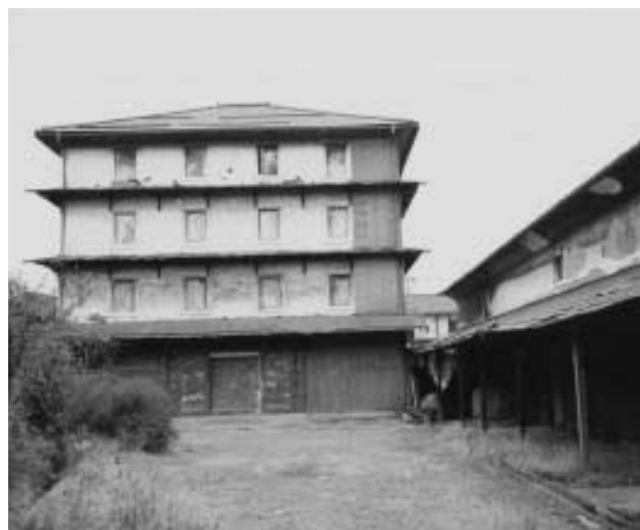
宮川の寒天倉庫／茅野市宮川／大正後期に繭倉を移築
