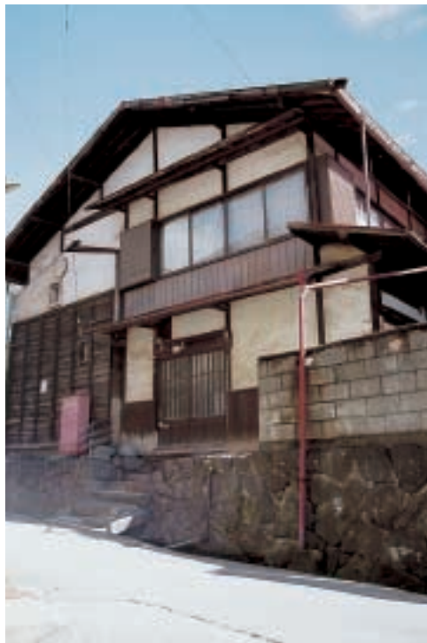
元町の建てぐるみ／諏訪市元町／明治末期
