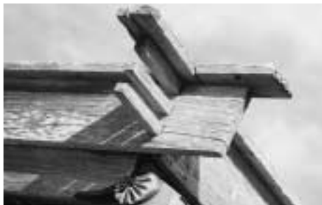
せき板と飾り破風板の納まり／せき板が柄（ほぞ）になっている一般的な例
