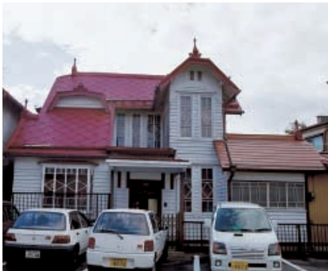
湯の脇の洋館／諏訪市湯の脇
