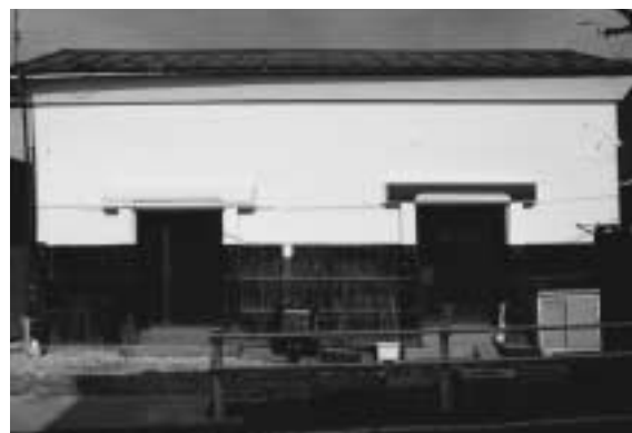
湯の脇の土蔵／諏訪市湯の脇／大正9年
