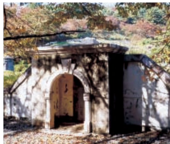
水月公園の配水池／下諏訪町東町中
