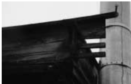
せき板と飾り破風板の納まり／せき板が柄（ほぞ）になっている一般的な例
