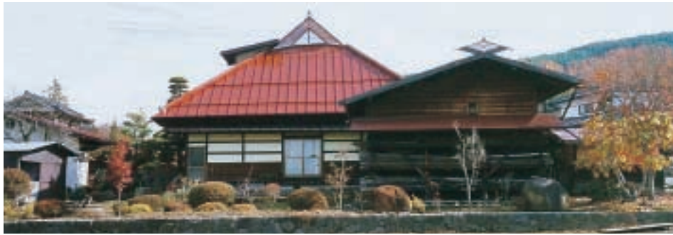
下古田のかぶと造り／茅野市豊平／明治後期に移築
