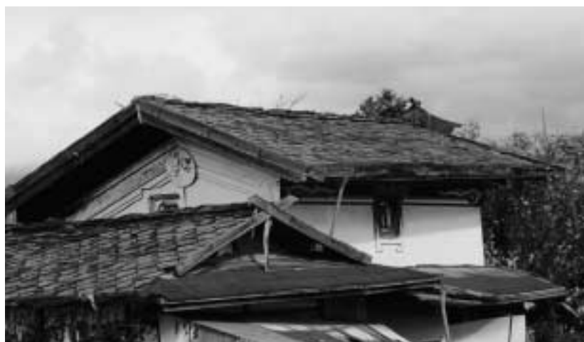
平石葺き（菱葺）屋根の倉と物置
