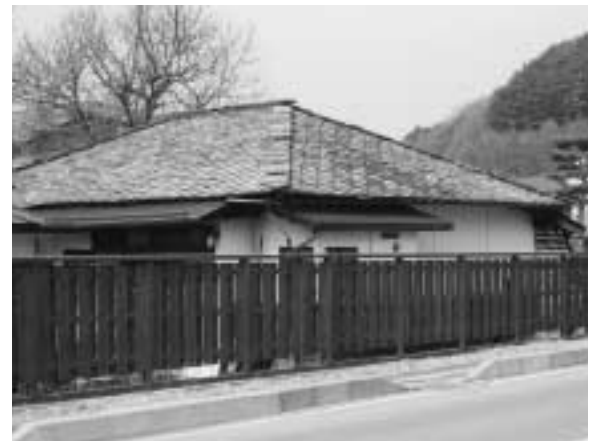
平石葺き（菱葺）屋根の住宅／寄棟
