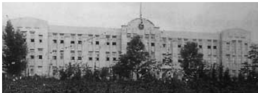
岡谷工業高校／岡谷市今井／現存しない
