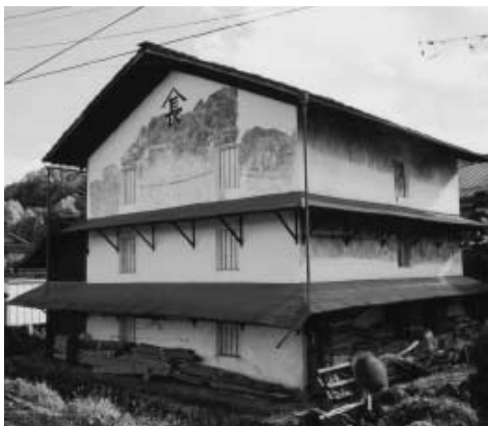
安国寺の寒天倉庫／茅野市宮川／昭和2年頃に岡谷の繭倉を移築
