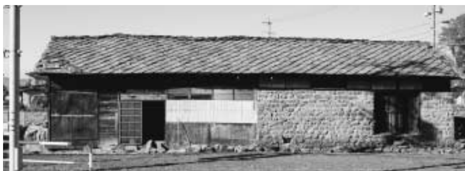
小川の旧天然ガス倉庫／諏訪市豊田
