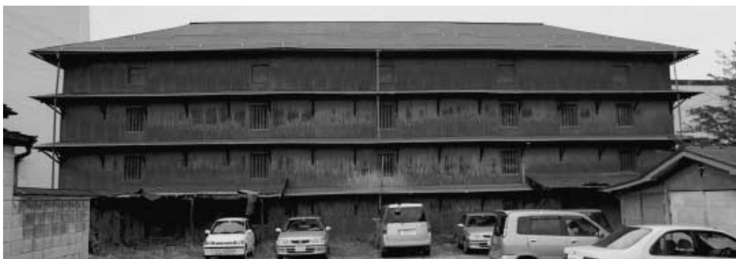
塚原の繭倉庫／茅野市ちの／現寒天倉庫
