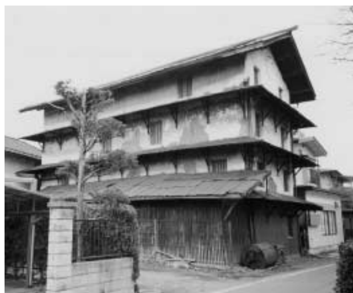
宮川茅野の寒天倉庫／茅野市宮川／繭倉を利用
