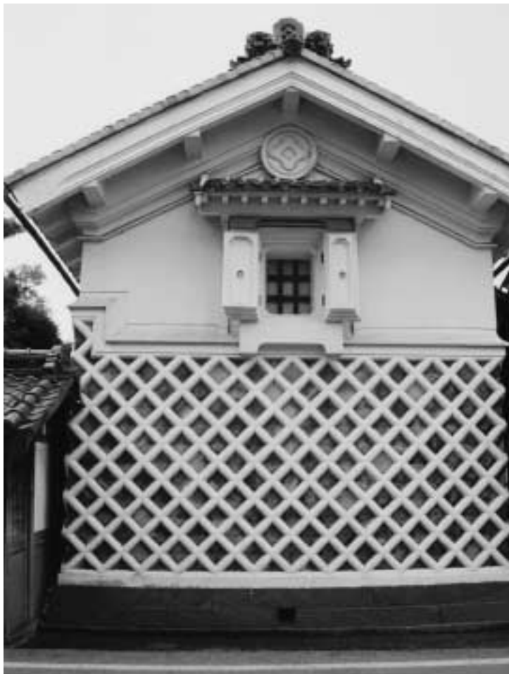
高木の土蔵／下諏訪町高木／明治初期
