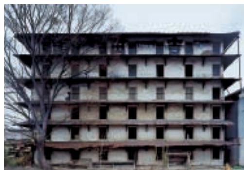
古田館六階建繭倉／岡谷市
